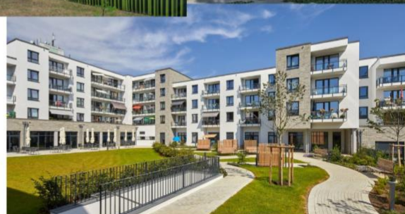
Bildquelle: Adlershorst Baugenossenschaft eG, Paloh Architekten
